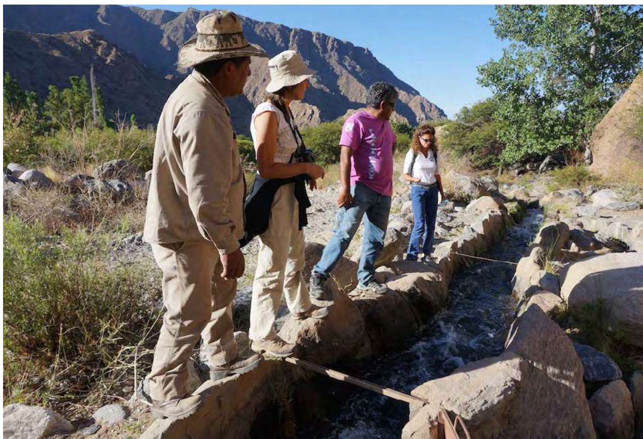
Inspection des canalisations en Argentine 2014
