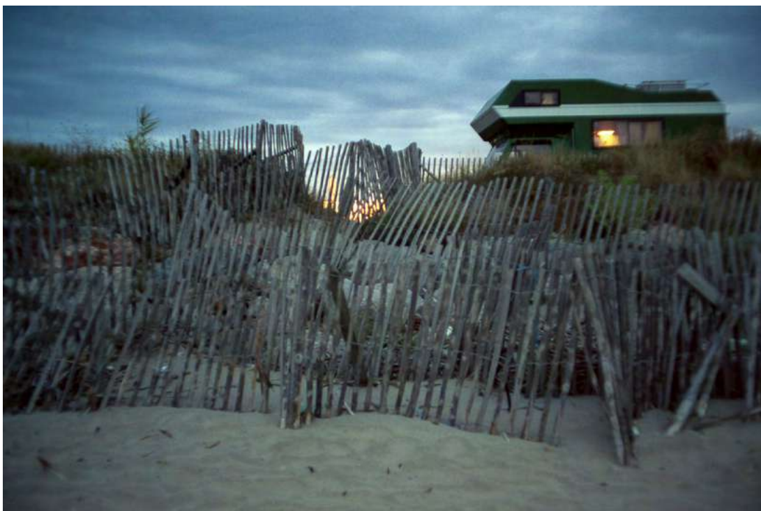
Un camping-car stationne avec vue sur mer, au bord d'une route protégée par des ganivelles. La pose de ganivelles fait partie des aménagements dits « doux », utilisé dans la protection des dunes littorales. Différents type d'aménagement sont réalisés pour tenter de fixer le trait de côte. Route d'Agde, Sète, Hérault, Juillet 2004.
